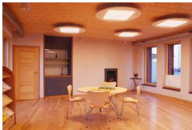
Flimmerfreie diffuse LED-Beleuchtung mit verschiedenen Lichtfarben und Beleuchtungsstärken
