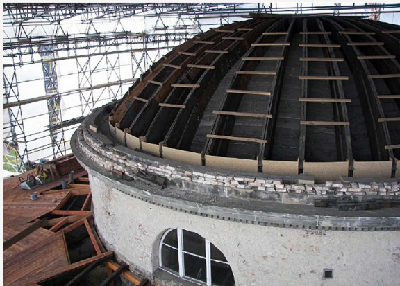
Freigelegte Konstruktion der Bohlenbinder- Kuppel ▶
