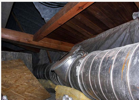
Gezielte Heizluftverteilung unter der Einhausung ▶
