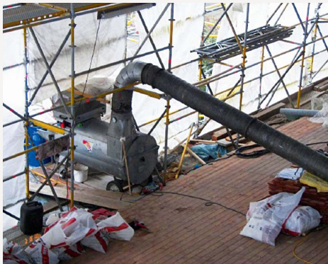
Einhausung und Heizluftgerät mit 350 KW Leistung ▶
