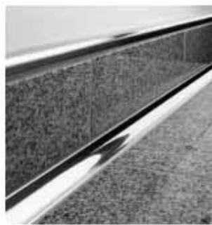
Abb.: Hohlkehlprofil aus Edelstahl für silikonfreie Boden- und Wandanschlüsse. Quelle: Fa. Schlüter, www.schluter.de
