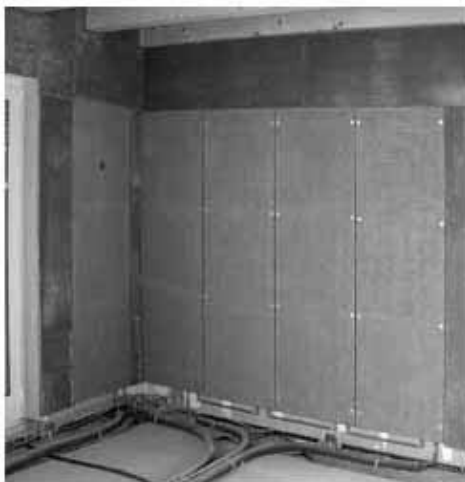
Abb.: Wandheizung aus Lehmbauplatten mit integrierten Verbundrohren Die Platten werden einschl. Fugen und Randbereiche mit Lehmputz verputzt. Quelle: Wem-Wandheizung GmbH, www.wandheizung.de
