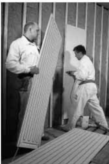
Abb.: Wandheizung aus Gipsfaserplatten mit integrierten Verbundrohren Die Platten werden einschl. Fugen und Randbereichen mit Lehmputz verputzt. Quelle: Variotherm Heizsysteme GmbH, www.variotherm.com
