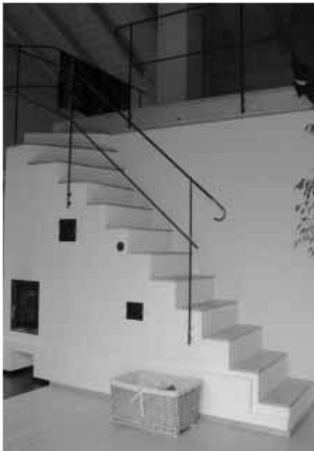
Abb.: Grundofen mit integriertem Warmwasser-Wärmetauscher , der das gesamte Gebäude beheizt und zugleich als Treppe dient Quelle: Wohnung + Gesundheit Nr. 127
