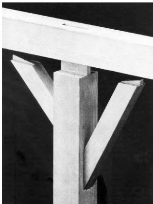
Abb.: Versetzter zweiseitiger Versatzeinschnitt bei Kopfbändern mit abgestirnten Strebenzapfen
