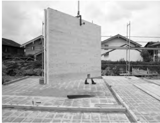
Eine Holzmassivwand wird mit einem Kran zu den vorbereiteten Schwellenhöhlern gehoben.
