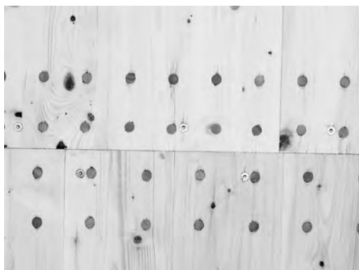
Horizontalstoß von 2 Holzmassivwänden
