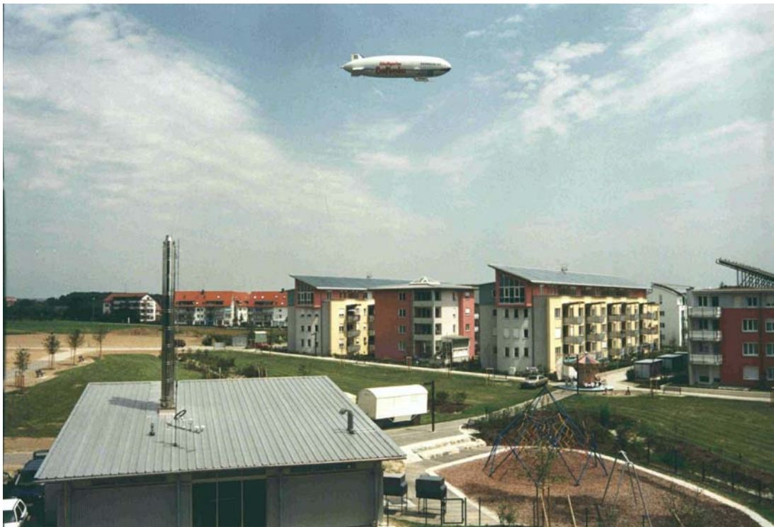
Bild 1: Innovative Technik in Wiggenhausen-Süd - Zeppelin-NT und modernste Solar- und Heizungstechnologie -
