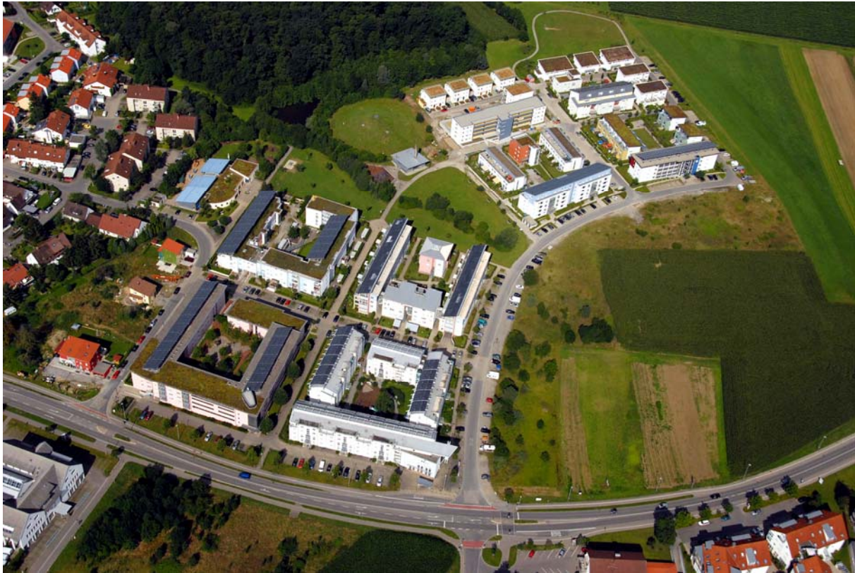
Bild 12: Solarstadt Wiggenhausen-Süd, Fertigstellung 1. und 2. Bauabschnitt
