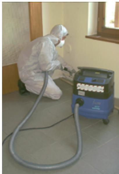
Fachgerechte Schimmelsanierung in Schutzkleidung, Feinstaubmaske und Industriestaubsauger mit HEPA-Filter
