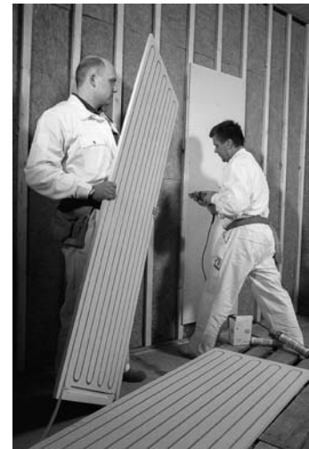
Abb. 23 Wandheizung aus Gipsfaserplatten mit integrierten Verbundrohren Die Platten werden einschl. Fugen und Randbereichen mit Lehmputz verputzt Quelle: Variotherm Heizsysteme GmbH, www.variotherm.com
