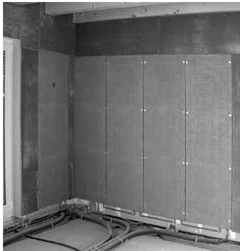
Abb. 22 Wandheizung aus Lehmbauplatten mit integrierten Verbundrohren Die Platten werden einschl. Fugen und Randbereiche mit Lehmputz verputzt Quelle: Wem-Wandheizung GmbH www.wandheizung.de
