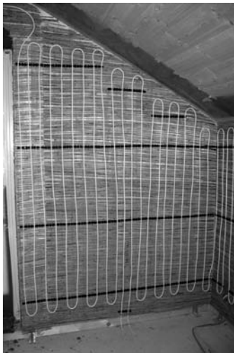
Abb. 21 Wandheizung mit Polypropylen-Röhrchen auf Schilfmatten als Putzträger Die Röhrchen können z.B. mit Lehm- oder Kalkputz überputzt werden.
