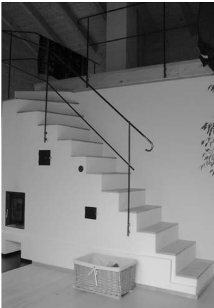
Abb. 9 a Grundofen mit integriertem Warmwasser-Wärmetauscher, der das gesamte Gebäude beheizt und zugleich als Treppe dient
